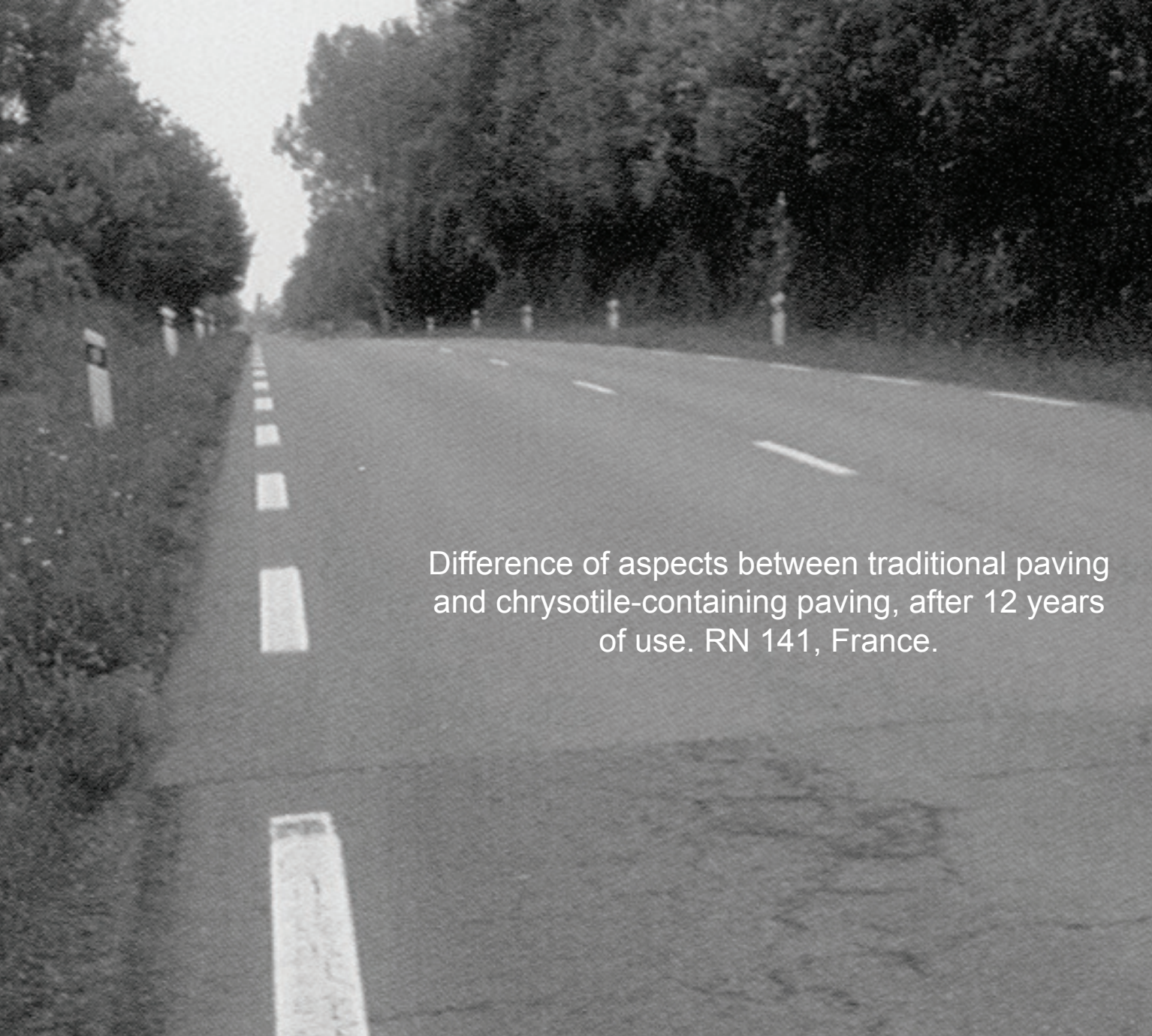
Différence d'aspect entre un enrobé traditionnel et un enrobé contenant de l'amiante après 12 ans de service – RN 141, France.
