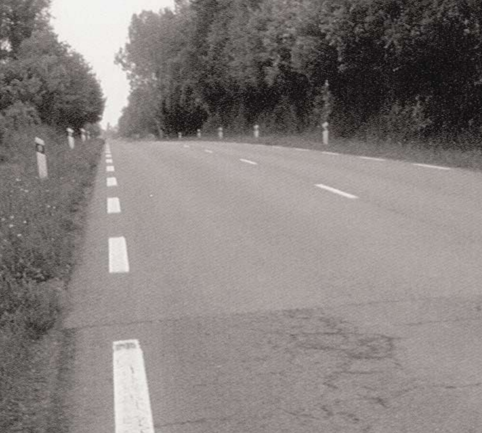
Diferencia de aspecto entre una pavimentación tradicional y otra que contiene crisotilo después de 12 años de uso. RN 141, Francia.
